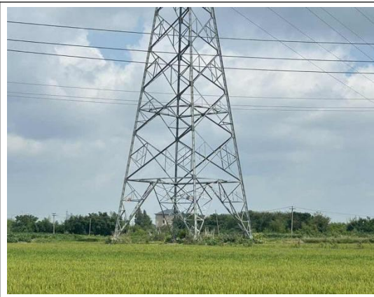
现有塔基植被恢复情况
