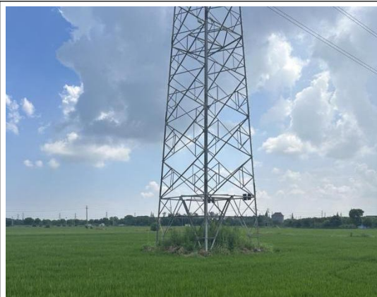
现有塔基植被恢复情况
