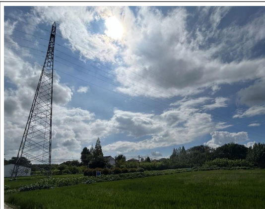
现有塔基植被恢复情况
